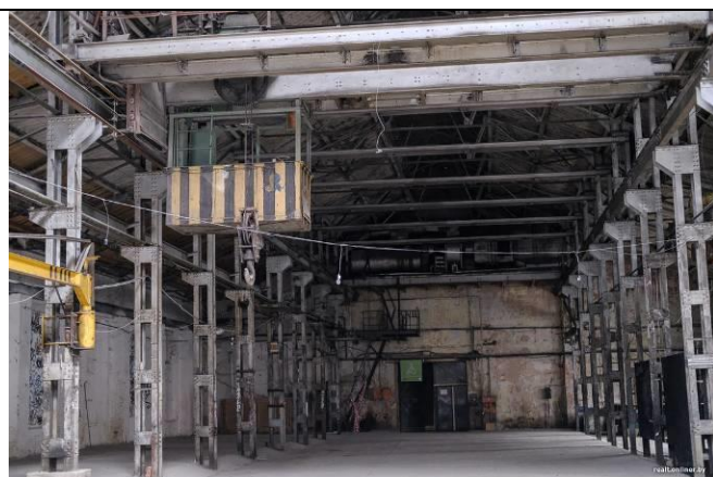
Рисунок 5. Интерьер здания «МЗОР», 2017 г. [2]
